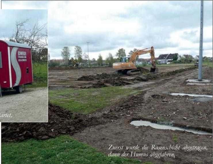
*Zuerst wurde die Rasenschicht abgetragen, dann der Humus abgefahren.*
